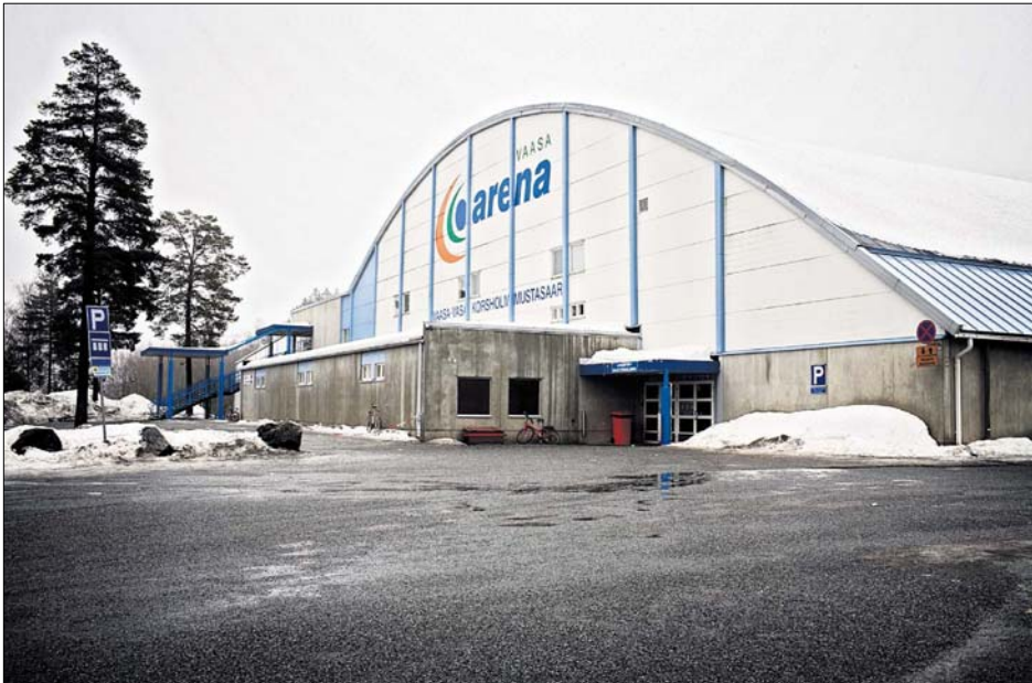
Kuntayhtymä haluaa laajentaa ja korjata Vaasan jäähallia. KUVA: TIMO ANNIAPALO
