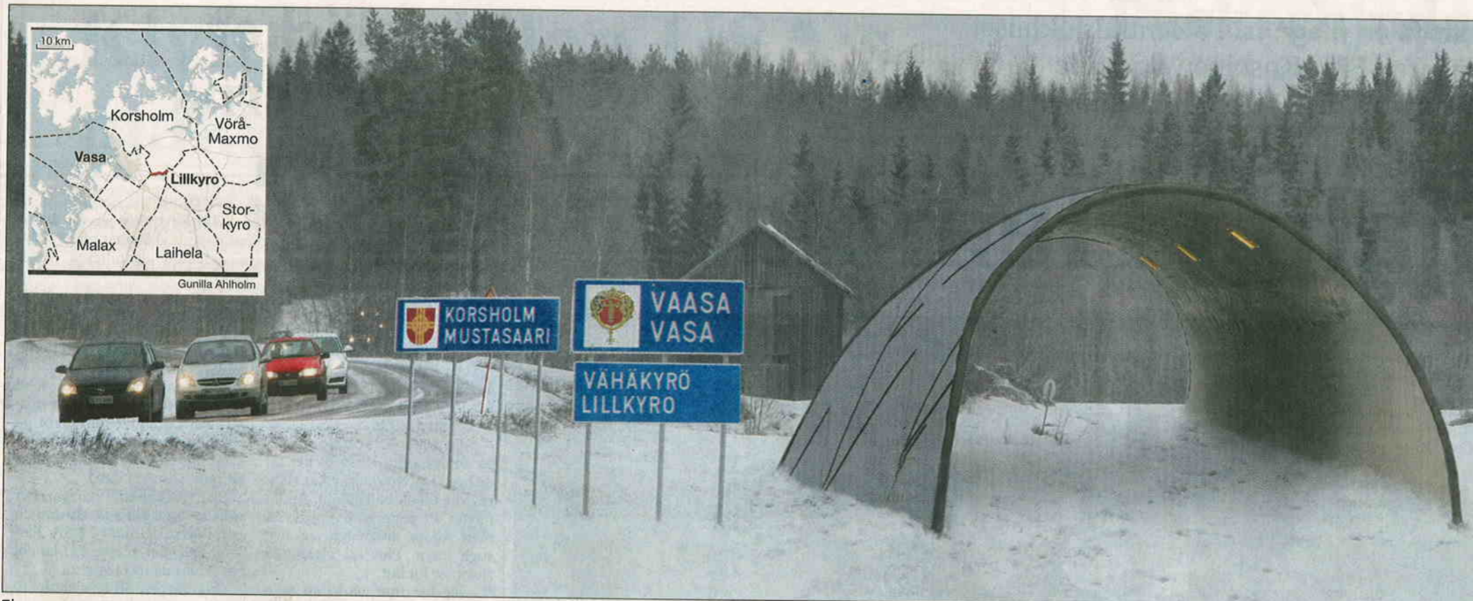
Elementen som man gör skidtunnlar av är lätta att koppla ihop. En första sektion har satts ut på prov ungefär där tunneln kommer att starta från Vasahället.
